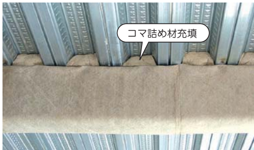
図13 コマ詰め材充填状況
