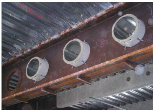
図15 マキベエスリーブ施工状況
