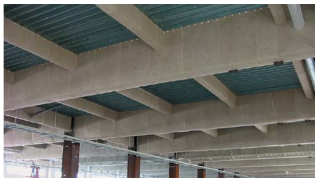
図3 マキベエ施工状況
