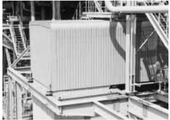
写真3 ダクト施工例
