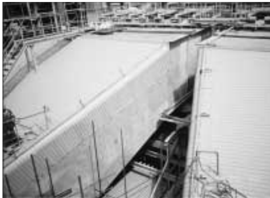
写真4 絞りダクトでの施工例
