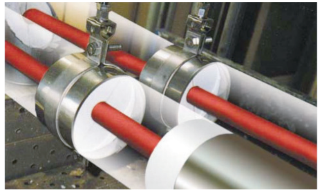
図13 「シルナートサポート」の施工例
