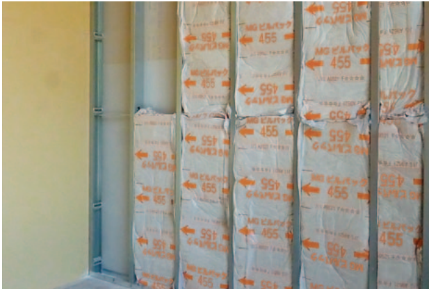
図2 間仕切壁施工例
