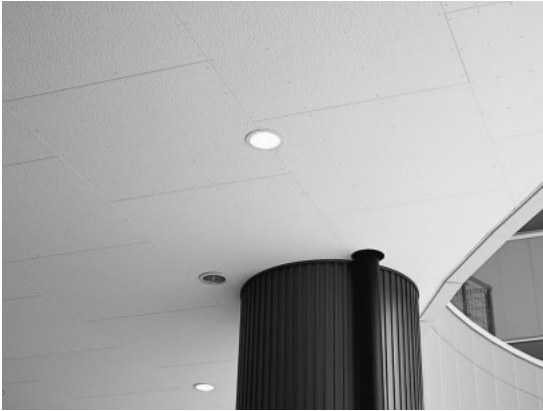
写真2 「エコラックス®」店舗天井での施工例
