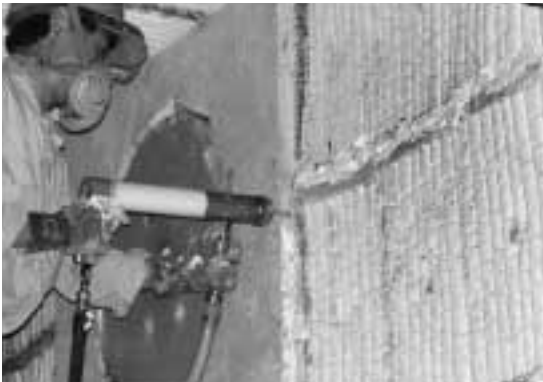
写真3 ノズル内への充填
