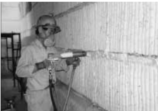
写真4 特殊ノズルによる施工
