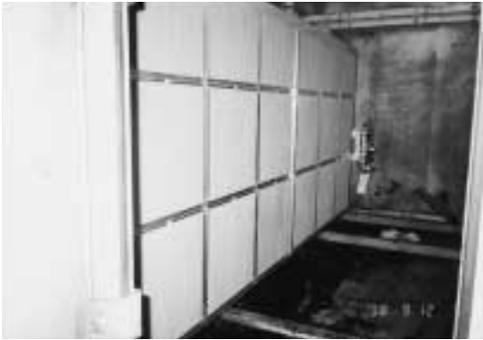
写真3 気化式加湿器エレメント施工例
