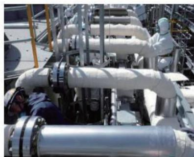
図2 防音ラギングの施工例
