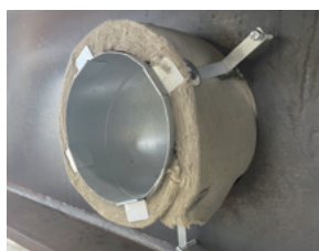
図6 マキベエスリーブ (設置時)
