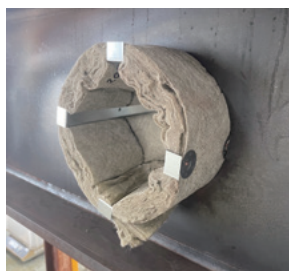
図3 マキベエスリーブN (設置時)
