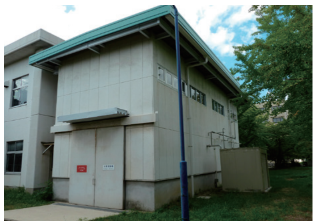
図1 水素実験棟の写真
