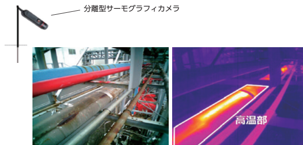
図3 分離型サーモグラフィカメラによる診断
