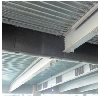
図12 マキベエBL施工
