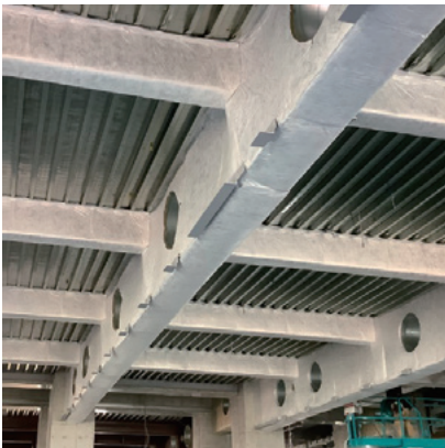
図13 マキベエWTA施工
