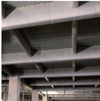
図11 マキベエWGR施工
