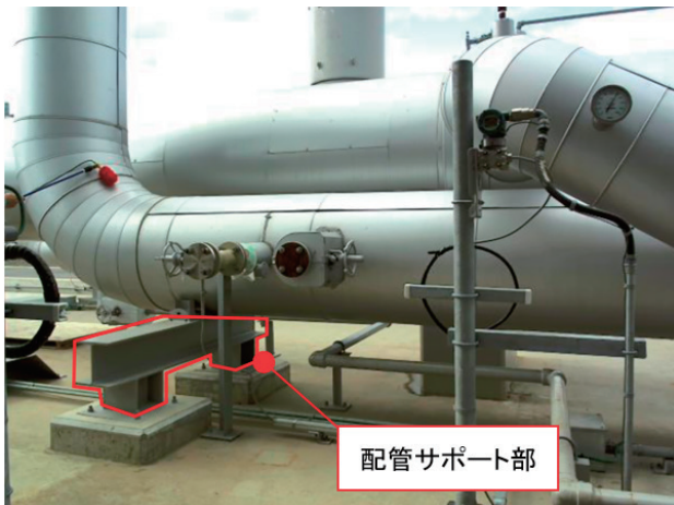
図3 配管と配管サポート部の例
