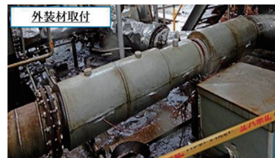
図6 屋外配管のCUI抑制効果試験状況
