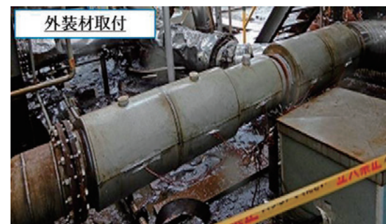
図6 屋外配管のCUI抑制効果試験状況
