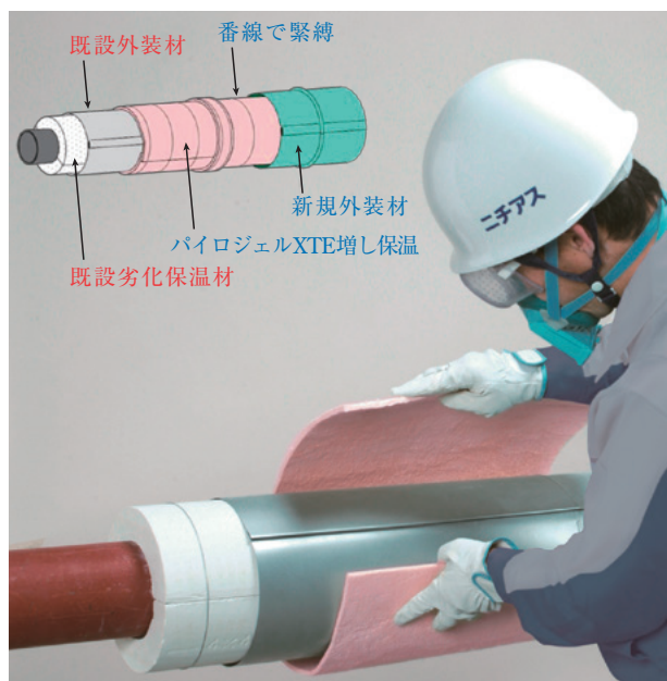
図5 増し保温工法概要
