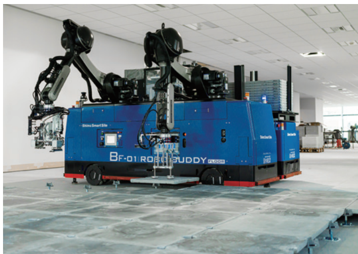
ロボットによるフリースアクセスフロア施工 (写真提供：清水建設(株))
