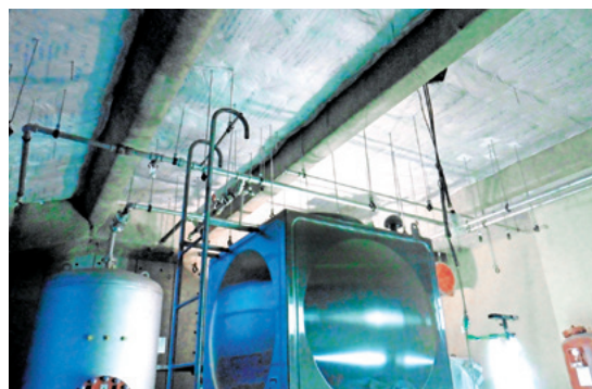
図8 「マキベエ® ダンネット」機械室天井の施工事例
