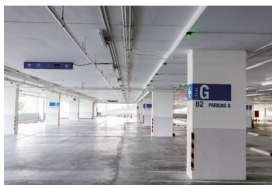
図1-b 店舗駐車場 天井使用部
