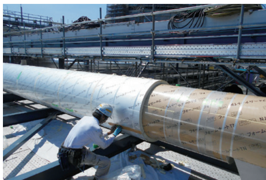
図11 LNG受入れ基地の配管保冷工事の一例
