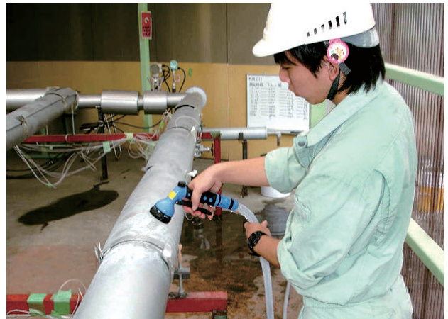
図4 保温材散水乾燥実験
