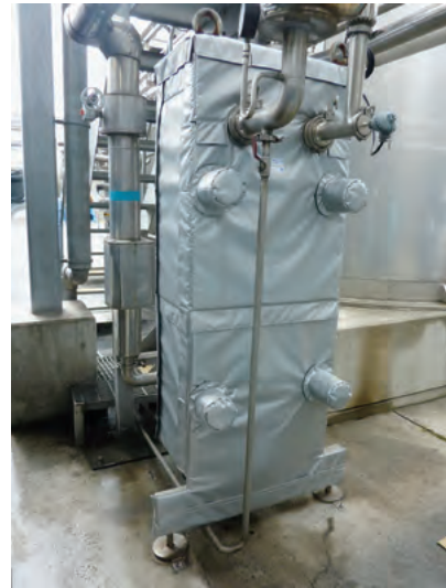
図4 熱交換器外周への取付例
