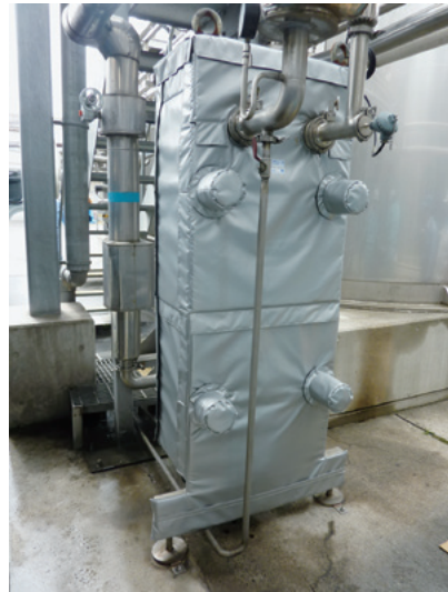
図4 熱交換器外周への取付例
