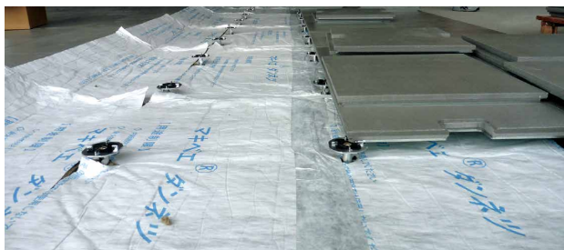
図8 「マキベエダンネット」を断熱材に用いたフリーアクセスフロアの施工例
