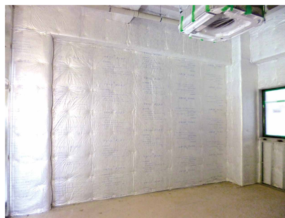
図3 機械室の断熱吸音用途での施工例
