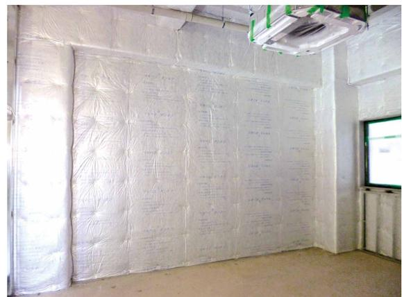
図3 機械室の断熱吸音用途での施工例
