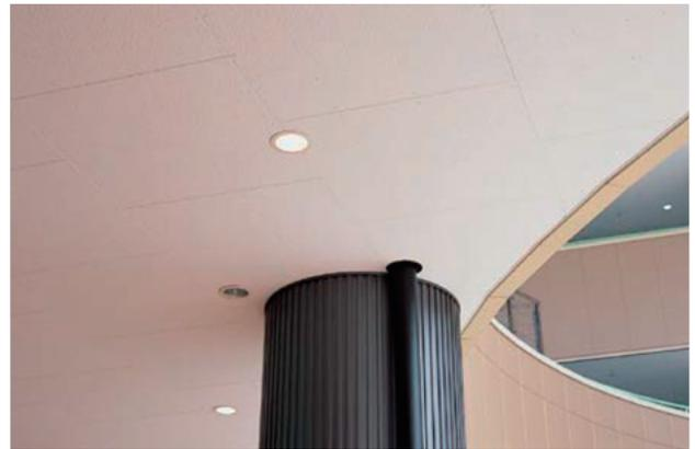
図4 けい酸カルシウム板の天井への施工例
