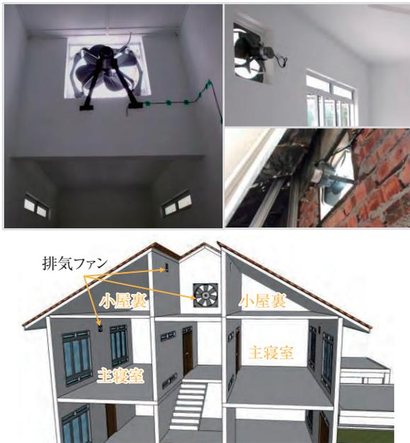
図2 設置した排気ファンとスリット窓
