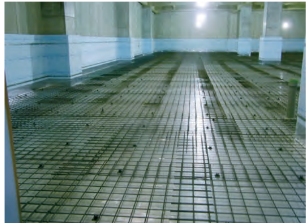
図8 床および立ち上がり部分の防熱工事
