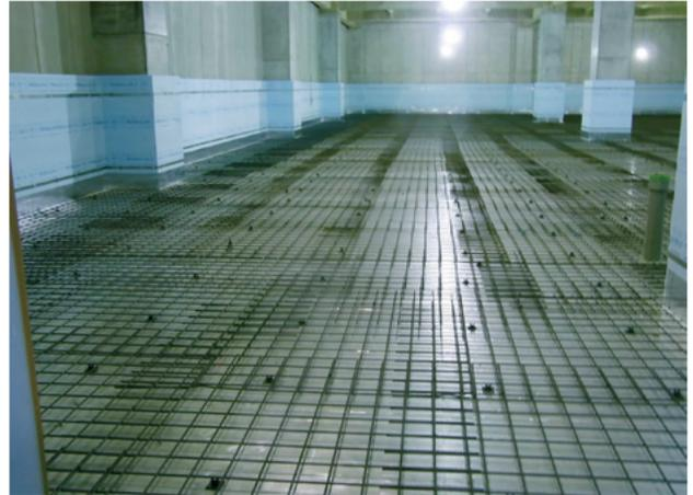
図8 床および立ち上がり部分の防熱工事
