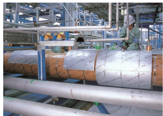
図18 「フォームナート カバー TN」による配管保冷施工
