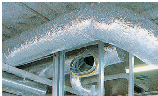
図1 配管の保温に用いられる表面化粧材付きMG製品
