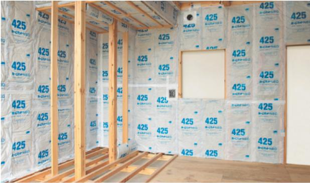
図4 「ホームマットNEO®」の施工例
