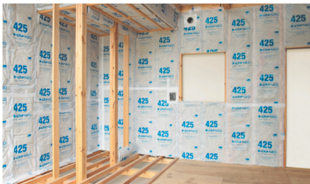
図4 「ホームマットNEO®」の施工例
