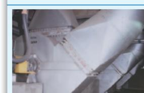
各種配管やダクトなどの煙道に使用される非金属製伸縮継手です。大口径ダクト配管などの熱膨張、振動によって生じる伸縮変位移動を吸収する製品です。
