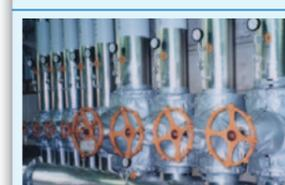
バルブ・フランジ・タービン・ポンプ・ボイラールーブリなどの保温に用いられる着脱自在で断熱性に優れた保温材です。屋外用として防水タイプもあります。
