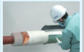
劣化した既設保温材を取り外すことなく、上から保温材を重ね巻きて低下した保温性能を回復させる保温機能回復工法です。
