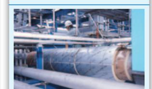
LNG 発電所・基地、船舶などの配管、貯蔵に使用される低温特性に優れた炭酸ガス発泡ウレタンフォーム断熱材です。
