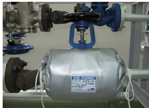
写真2 エネサーモ取付後のバルブ
