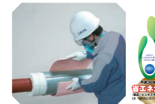
保温メンテナンス工事「増し保温® 工法」
