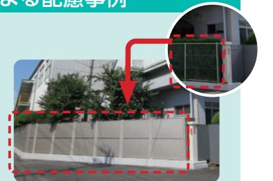
工場のフェンスを金網から防音タイプに変更し、騒音対策を実施
