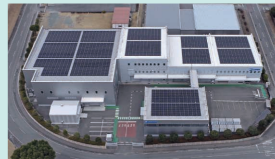
(株)熊本ニチアスの太陽光発電設備
