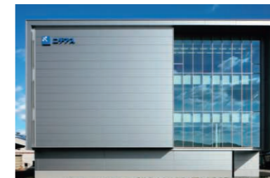
フッ素樹脂加工品の生産増強およびBCPの目的で王寺工場を活用(王寺工場新1号棟)
