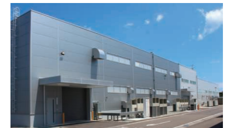
無機断熱材製品の生産増強として福島ニチアスの生産エリアを増築(株)福島ニチアス第8工場)
