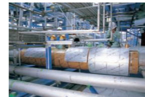
保温保冷工事
