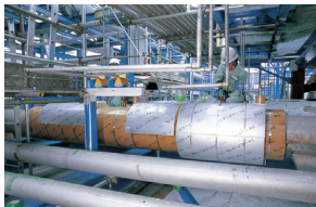
保温保冷工事
