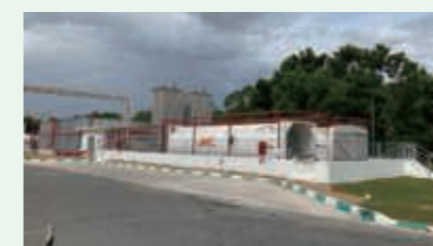
① LNG貯蔵設備の導入 (NICHIAS FGS SDN. BHD.メタコート2号ライン)
