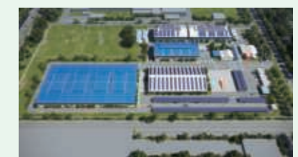
③ 太陽光パネルの導入 (NT RUBBER-SEALS SDN. BHD. 640kW)
