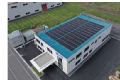
結城工場 2022年9月稼働
