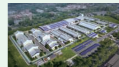
② 太陽光パネルの導入 (NICHIAS FGS SDN. BHD. 1,280kW)
