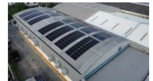
NICHIAS (THAILAND) CO., LTD. 2022年8月稼働
