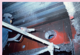
吹付け工法(従来工法)のようす
