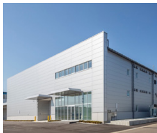
福島ニチアス第7工場
