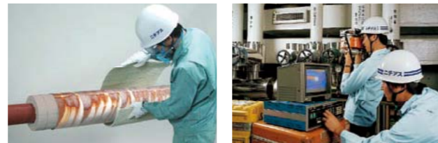
既設保温材を取り外さずに巻き付けるメンテナンス工法
