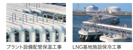
プラント設備配管保温工事
