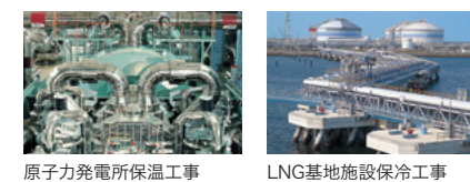
原子力発電所保温工事
