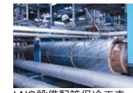
LNG設備配管保冷工事
