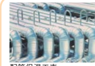
配管保温工事
