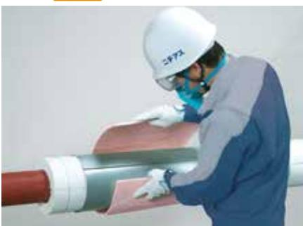
水を含んで性能が低下した保温材を取り外すことなく、保温性能を回復させる工法です。エネルギーロスを抑え、内部流体の温度を保ちます。
