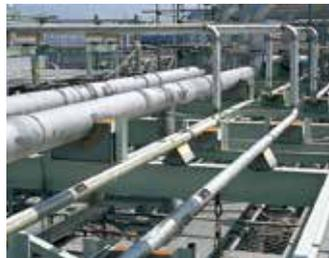
低温流体配管用の支持材です。断熱性と耐荷重性を備え配管の冷熱を断ちます。
