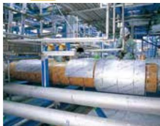
LNG基地、LNG船、配管、タンクやその他設備への保冷材の取り付け工事です。
