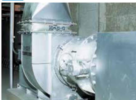
配管やダクトなどの煙風道に使用される非金属製伸縮継手です。ダクトの熱膨張や収縮を吸収します。
