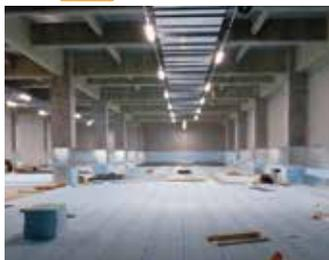
食品や医薬、化学品などの大型冷蔵倉庫の防熱工事です。お客さまの要望に合わせて、防熱材の種類や厚みの選定から、現場での取り付けまで一貫して行っています。
