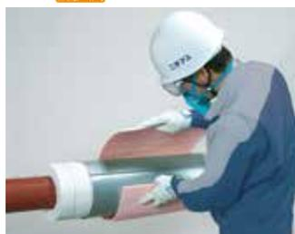
水を含んで性能が低下した保温材を取り外すことなく、保温性能を回復させる工法です。エネルギーロスを抑え、内部流体の温度を保ちます。
