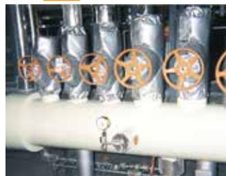
蒸気ラインの配管・バルブ類、熱交換器等に幅広く使用される断熱材です。放熱を断つことで省エネや作業環境改善が図れます。
