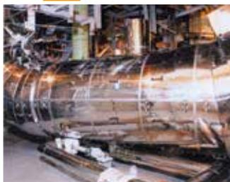
原子炉の圧力容器や各種機器、配管に使用される着脱が容易な断熱材です。遮へい機能も付与できます。
