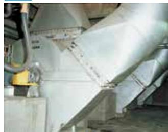
配管やダクトなどの煙風道に使用される、非金属製伸縮継手です。ダクトの熱膨張や収縮を吸収します。
