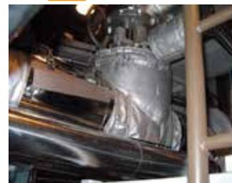
配管や機器、弁などに使用される着脱が容易な断熱材です。配管などから発生する熱を断ちます。
