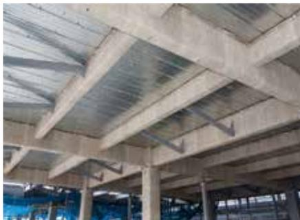
鉄骨構造ビルの梁や柱に使用される、ロックウール製の耐火被覆材です。火災時の火を断ちます。
