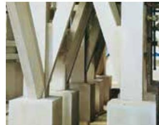
機器支持架台の屋外露出部の柱・梁などに施工される、耐火・耐冷被覆材です。火災時の火を断ちます。
