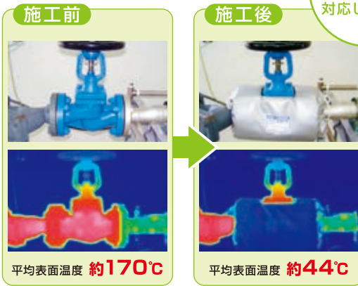
着脱式 フレキシブル断熱材 エネサーモ® R 施工例 (蒸気バルブ10K玉型弁)
