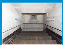
不定形耐火物を使用した 築炉工事施工例
