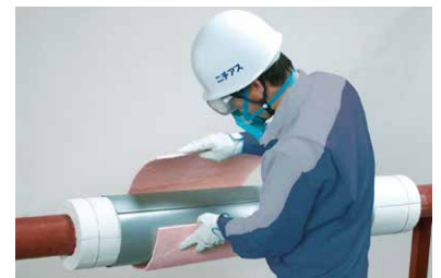
増し保温® 工法
