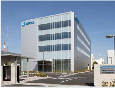
鶴見総合事務所棟 (神奈川県横浜市)
