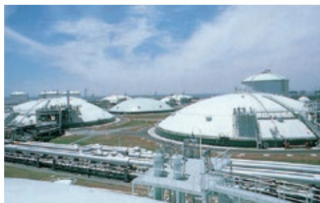
LNG 地下タンク
