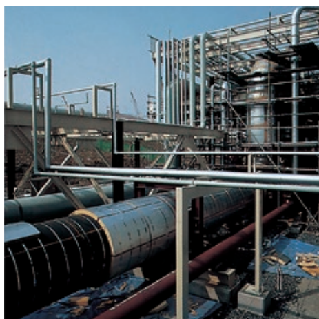
配管（保冷）施工中
