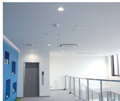
エレベーターホール
