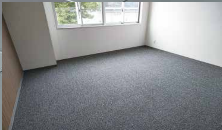
施工例 (タイルカーペット敷設)
