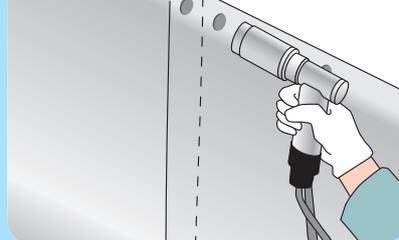
耳部が弛まないように伸ばし、固定ピンを溶接します。
