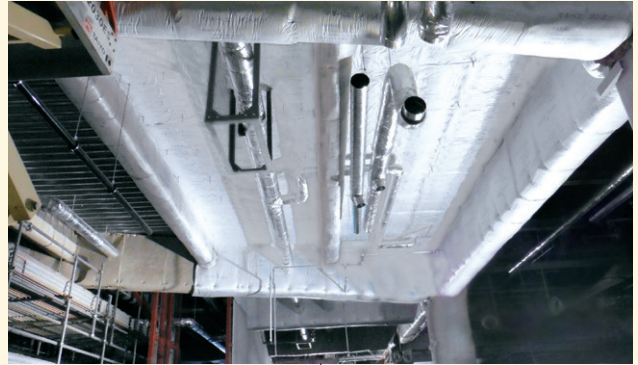
天井、見上げ床 不燃・断熱
