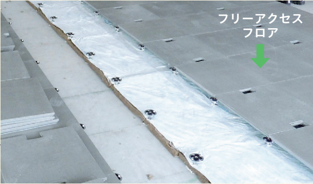
フリーアクセスフロア下 断熱・発塵抑制
